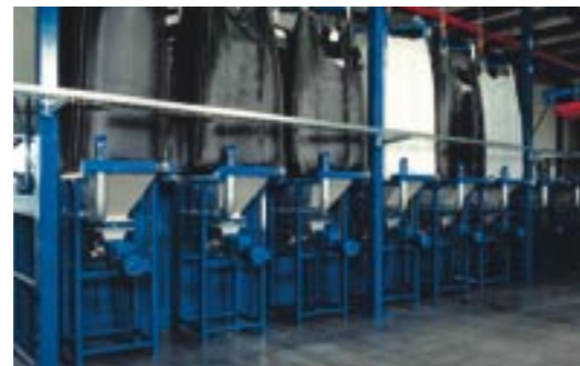
Großkomponentenlagerung und automatische Verwiegung
